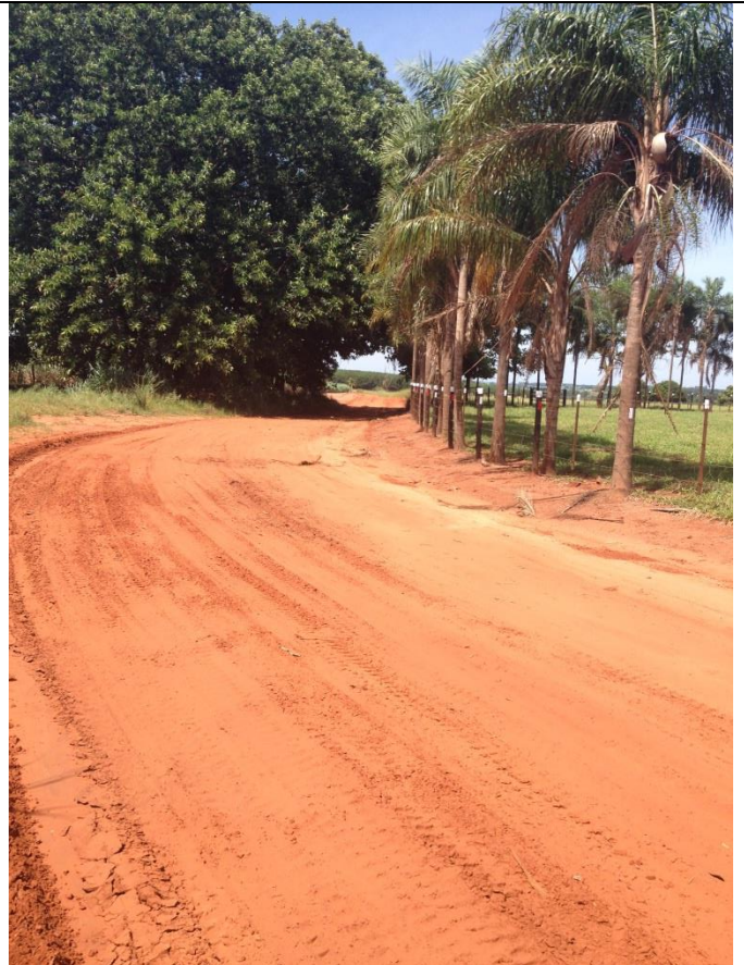
Estrada MCB 134 / Trecho C
