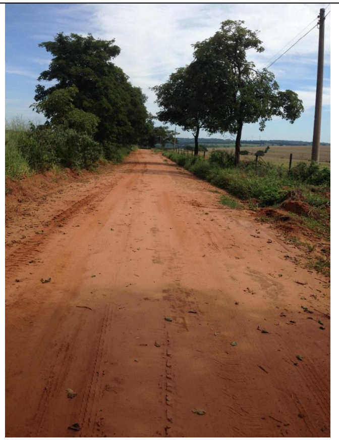
Estrada MCB 050 / Trecho D
