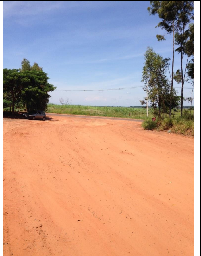
Estrada MCB 134 / Trecho C
