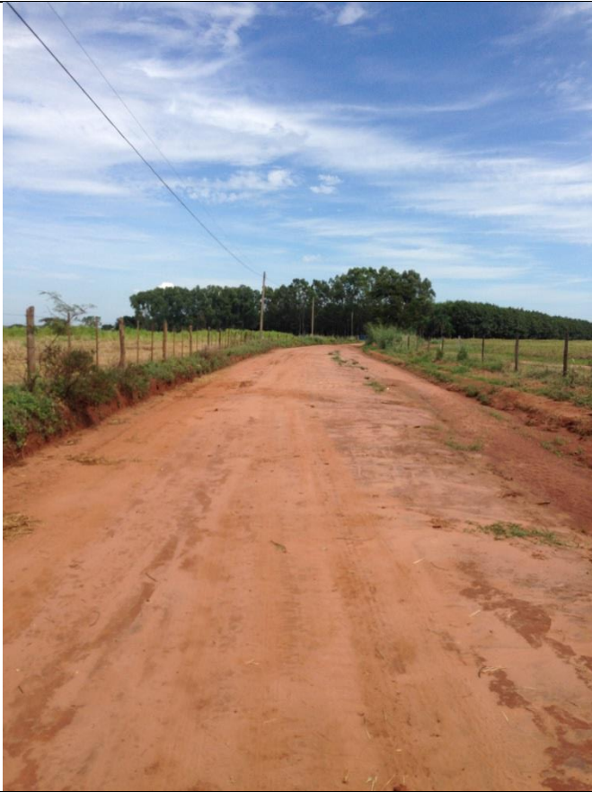
Estrada MCB 050 / Trecho D
