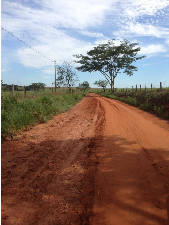
Estrada MCB 050 / Trecho D
