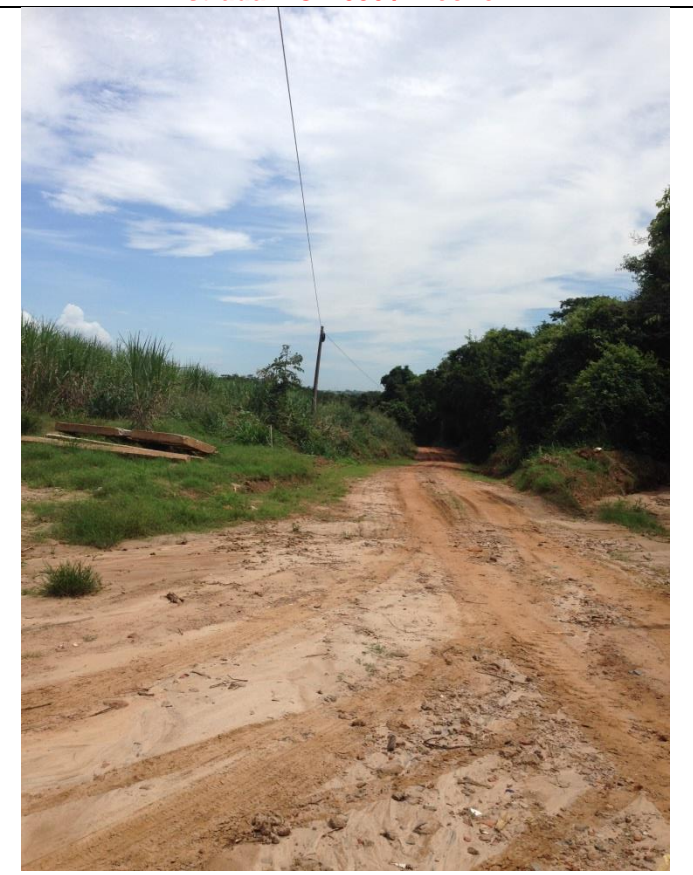
Estrada MCB 050 / Trecho D
