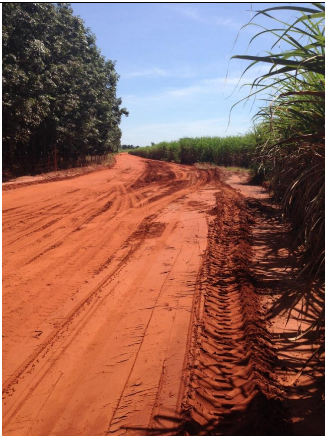
Estrada MCB 134 / Trecho C
