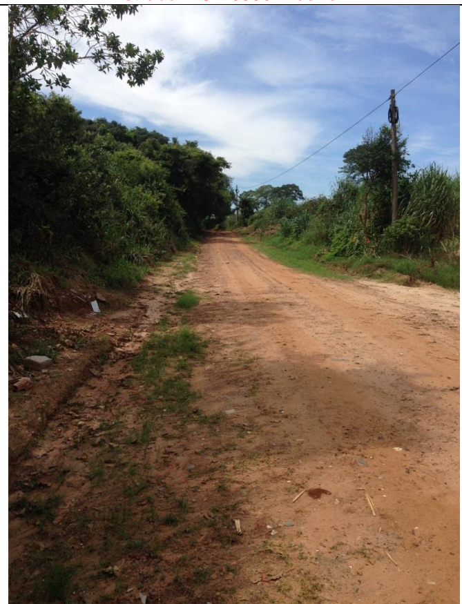
Estrada MCB 050 / Trecho D
