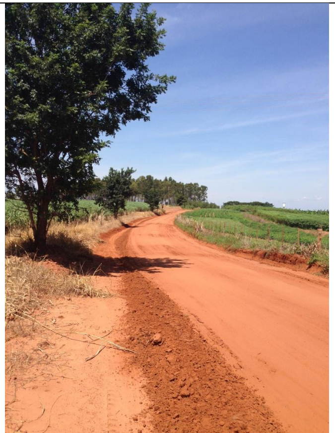
Estrada MCB 134 / Trecho C
