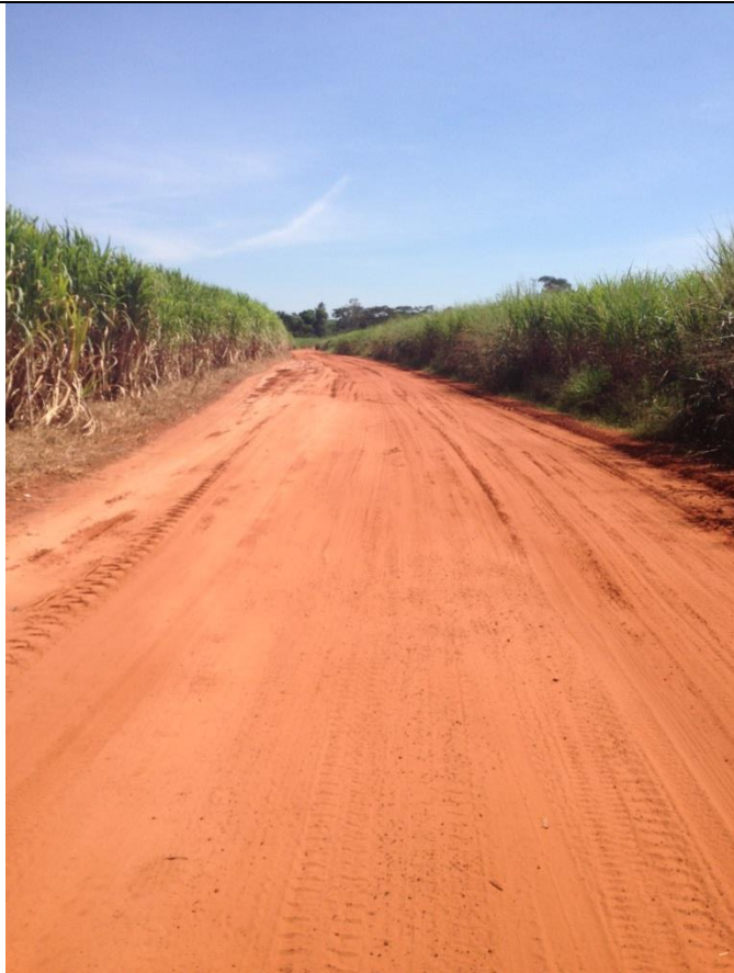
Estrada MCB 134 / Trecho C
