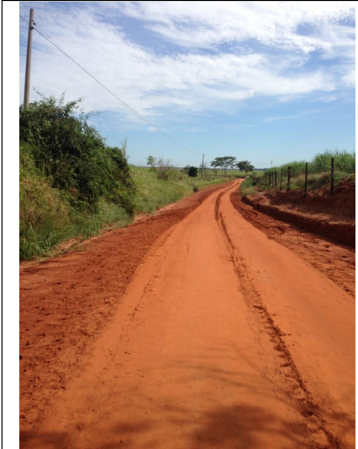
Estrada MCB 134 / Trecho C
