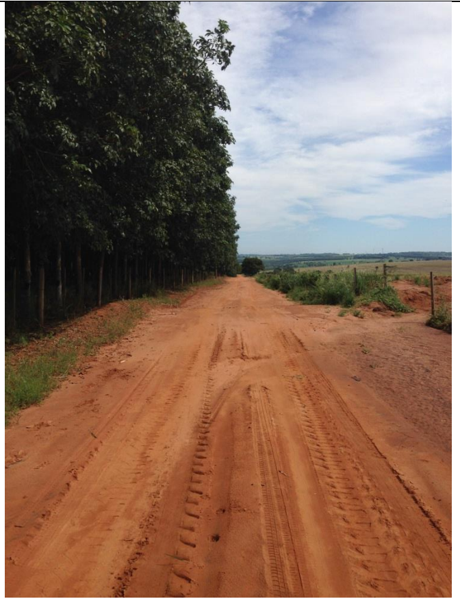
Estrada MCB 050 / Trecho D
