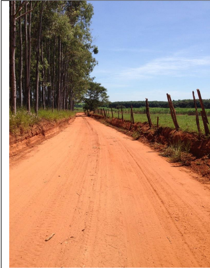
Estrada MCB 134 / Trecho C
