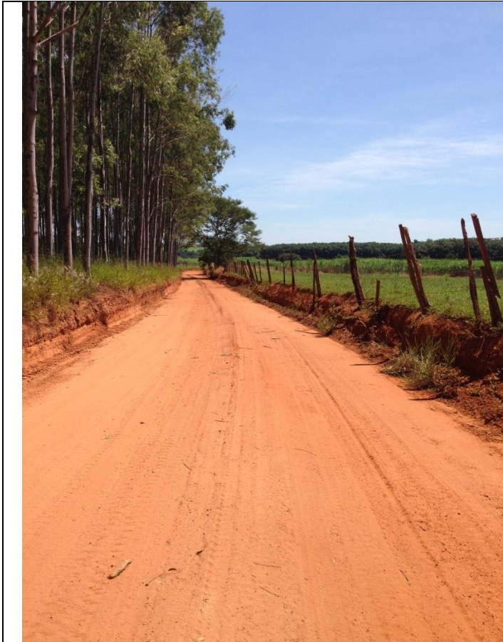
Estrada MCB 134 / Trecho C
