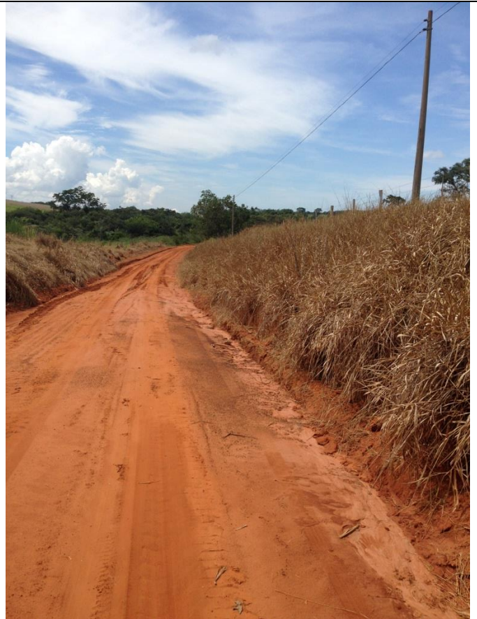
Estrada MCB 050 / Trecho D
