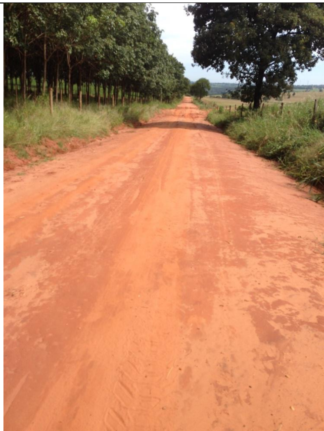
Estrada MCB 050 / Trecho D
