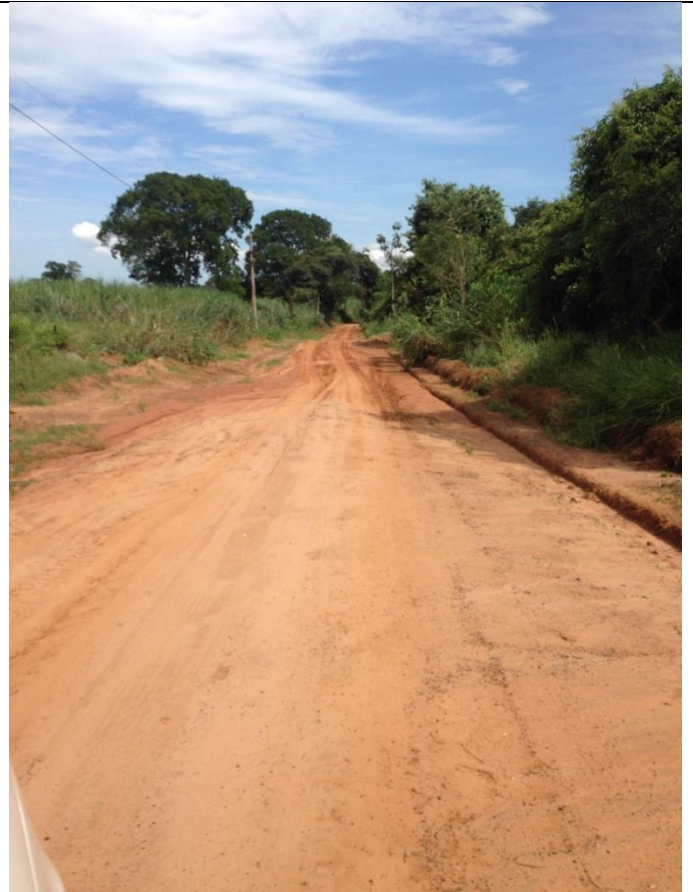
Estrada MCB 050 / Trecho D
