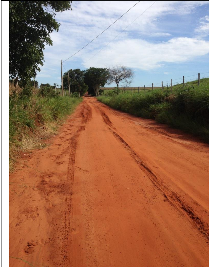
Estrada MCB 050 / Trecho D
