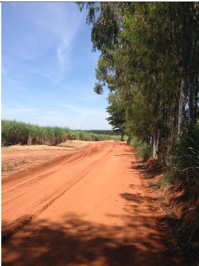
Estrada MCB 134 / Trecho C
