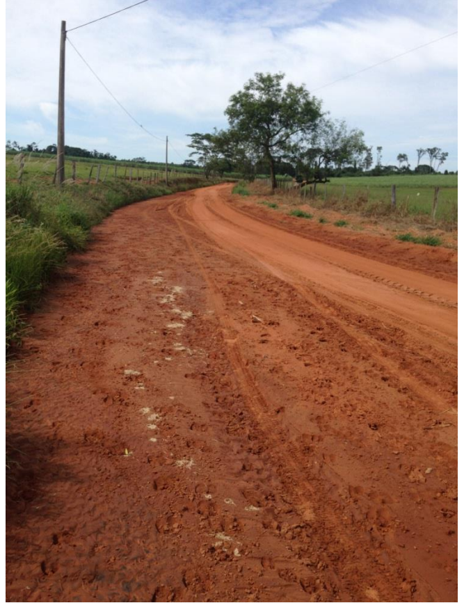
Estrada MCB 050 / Trecho D
