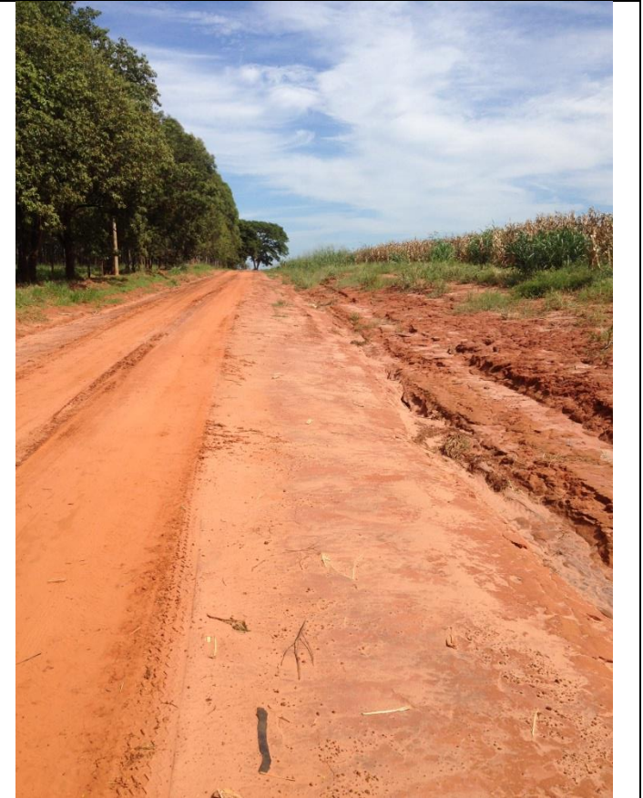
Estrada MCB 050 / Trecho D
