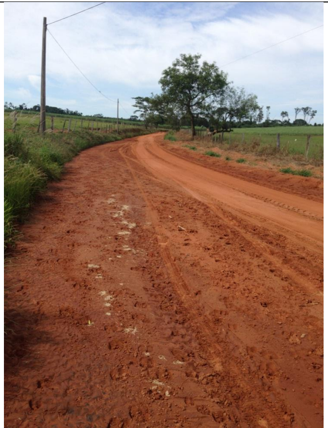
Estrada MCB 050 / Trecho D
