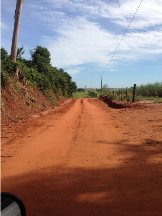
Estrada MCB 050 / Trecho D
