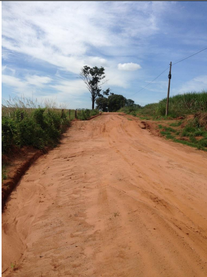
Estrada MCB 050 / Trecho D
