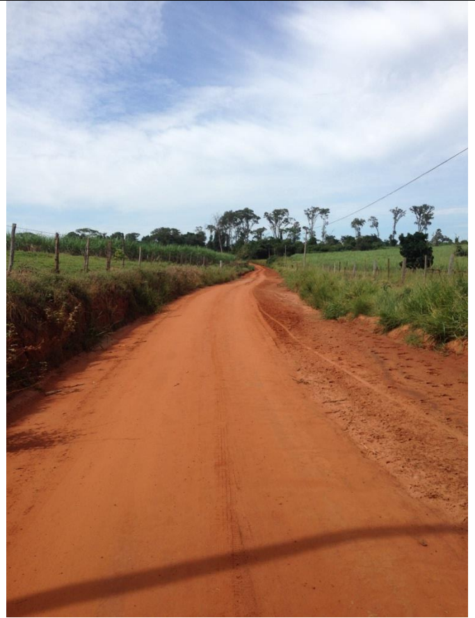
Estrada MCB 050 / Trecho D
