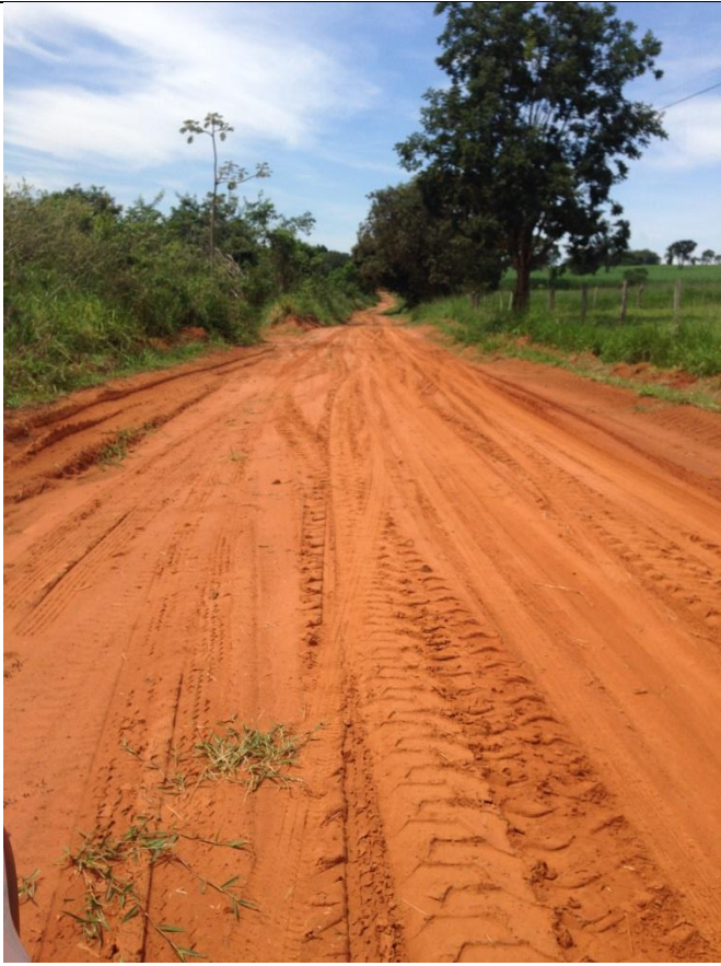
Estrada MCB 050 / Trecho D
