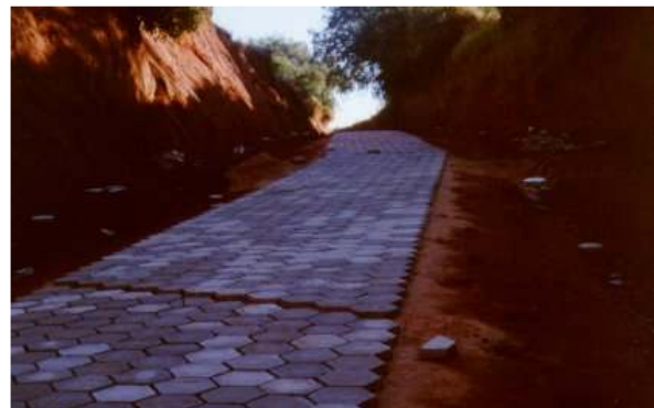
FOTO REVESTIMENTO ALTERNATIVO TIPO B1
