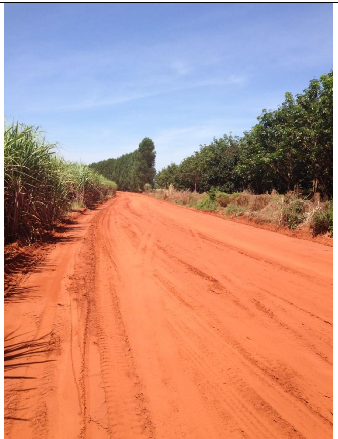
Estrada MCB 134 / Trecho C
