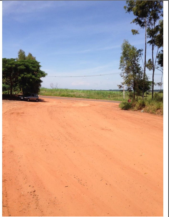
Estrada MCB 134 / Trecho C
